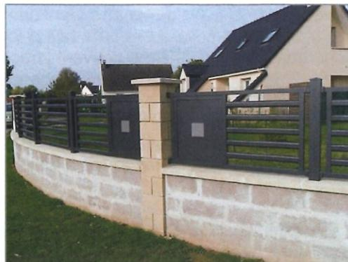
Il est donc proposé de rehausser cette hauteur maximale du muret en tenant compte de cette pratique constructive de 3 parpaings superposés :  $3 \times 20 \text{ cm} = 60 \text{ cm}$  minimum (en raison du mortier de jointoiement). Cela sera plus pratique pour les résidents dans la mise en œuvre technique du chantier.
